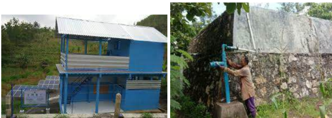
Gambar 4.5. Bak Pemanenan Air Hujan di Kabupaten Gunungkidul
